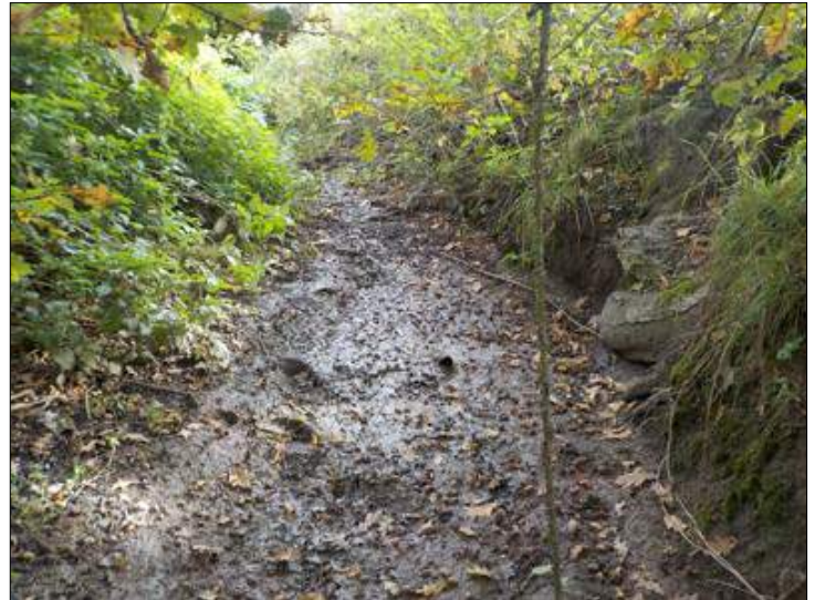
Amont de la Prédécelle, déclassé en fossé (Pecqueuse, 91)
